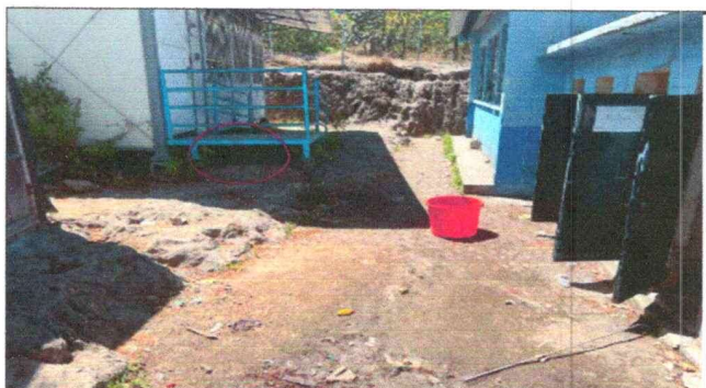
Foto 3: Construccion de muro de retencion, para proteccion y nivelación
