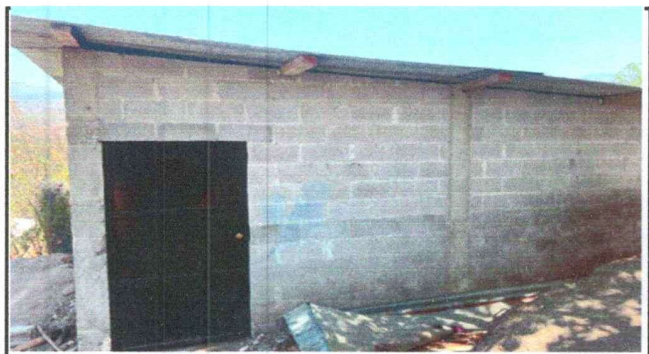
Foto 2: Repello por dentro y fuera de cocina
