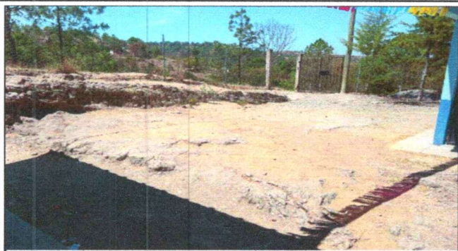
Foto1: Area de corte y nivelacion de terreno, posteriormente será pavimentado
