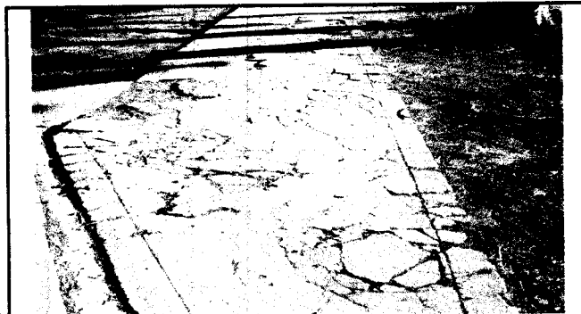
Reparación de piso, torta de cemento
