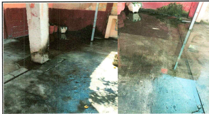
Foto 3: Reparación de cuneta de concreto
