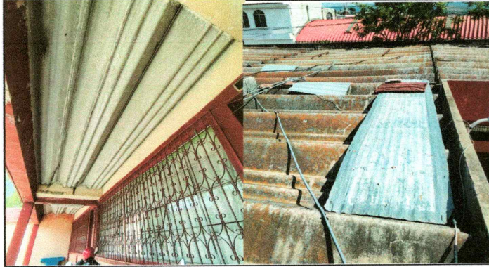
Foto1: Sustitución por lámina troquelada aluzinc calibre 26
