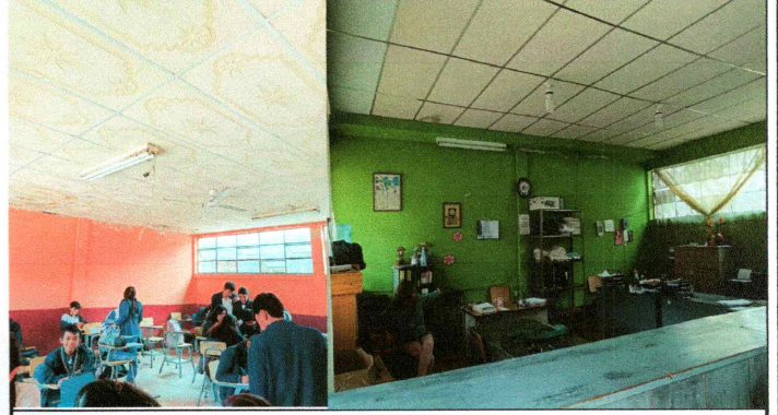
Foto 2: Sustitucion de estructura de soporte
