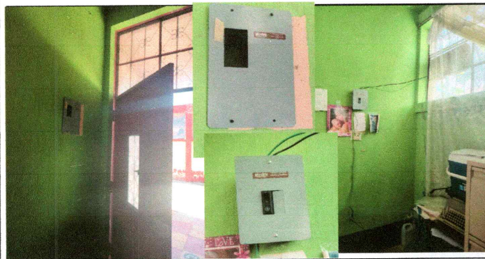
Foto 5: Sustitucion de focos flipones
