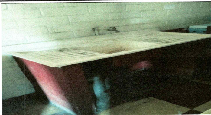
Foto 7: Sustrucción de lavatrastos
