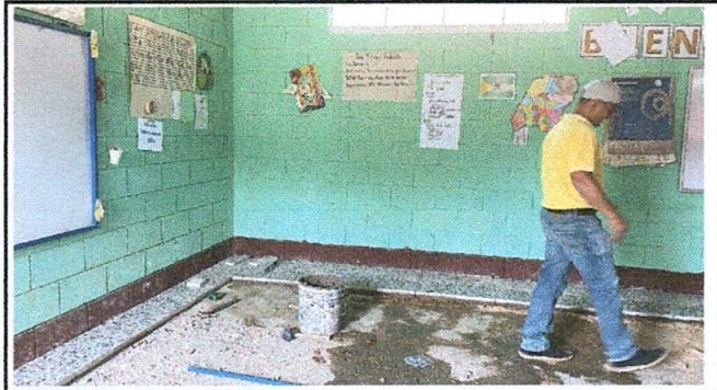
COLOCACIÓN DE PISO EN EL AULA DE CUARTO GRADO SECCIÓN .
