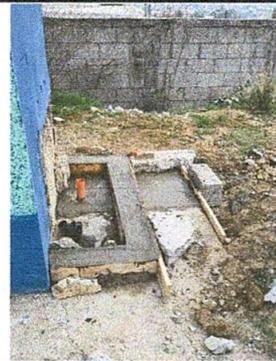
Foto 6: Arreglo de drenaje previo a instalación de pila
