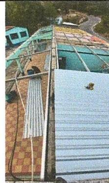
Foto 4: Instalación de lámina aluzinc
