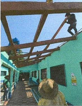
Foto 1: Proceso de desmontaje de estructura de madera
