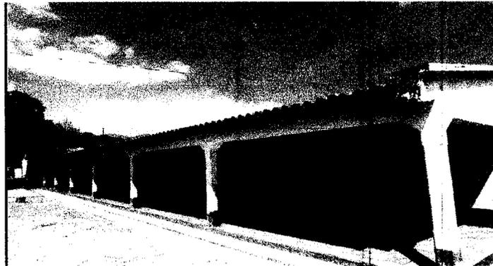
Foto 4: Techo sin canales ni caídas de agua pluvial
