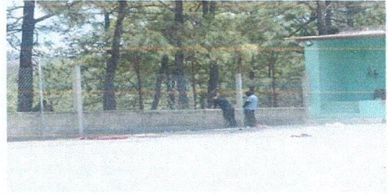
Sustitución de malla en muro perimetral
