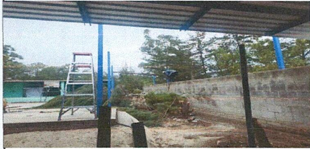
sustitución de lámina por lámina troquelada aluzinc
