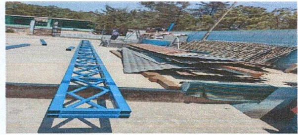
sustitución de estructura de soporte de mader por metal
