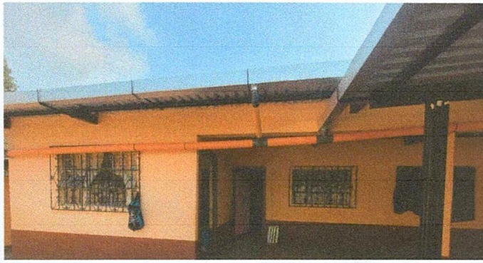
Foto : Sustitución de canal de metal
