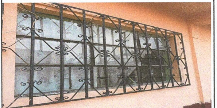
Foto 6: Sustitución de vidrios
