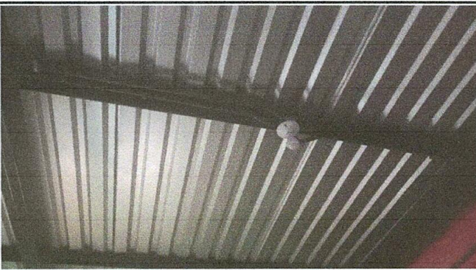
Foto 3 : Reparación de cabliado eléctrico
