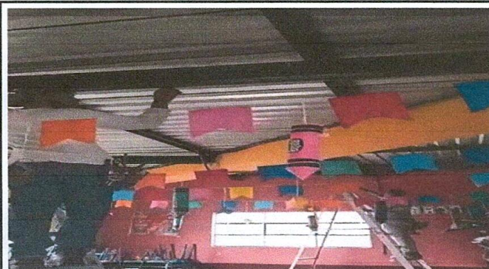
Foto 3 : Reparación de cabiado eléctrico
