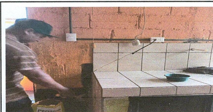
Foto 5: Reparación de azulejos en muebles de cocina
