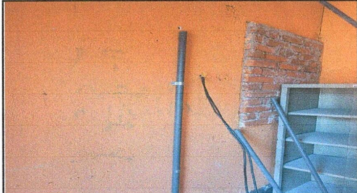
Foto 4: Sustitución de tomacorrientes dobles
