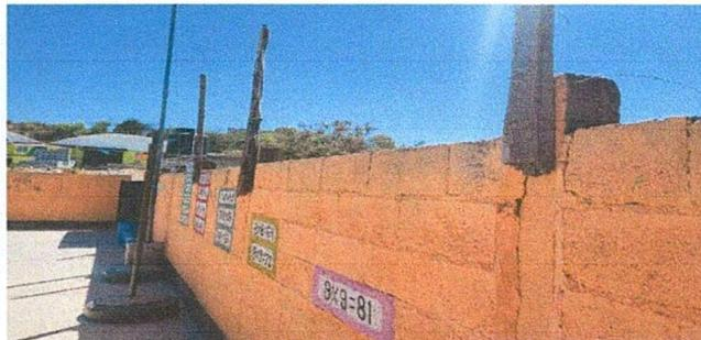
FOTO 2: Reparación de muro perimetral de blok con tubo y malla galvanizada , solores intermedias y columnas
