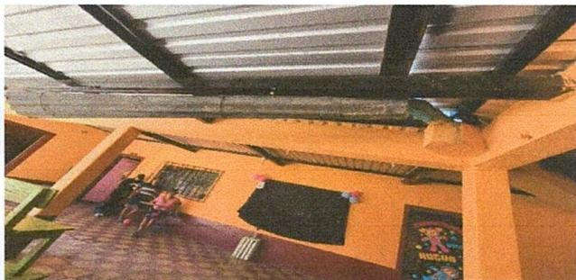
FOTO: Susustitución de canal de metal
