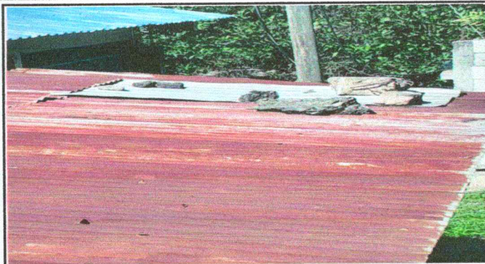
Foto 2: sustiucion de lammina
