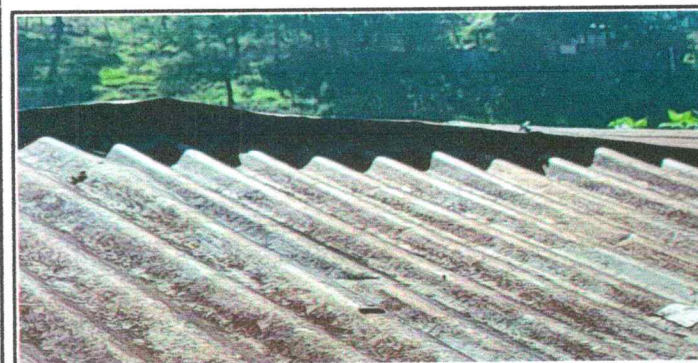
Foto 5: Sustitucion de soporte de capote.
