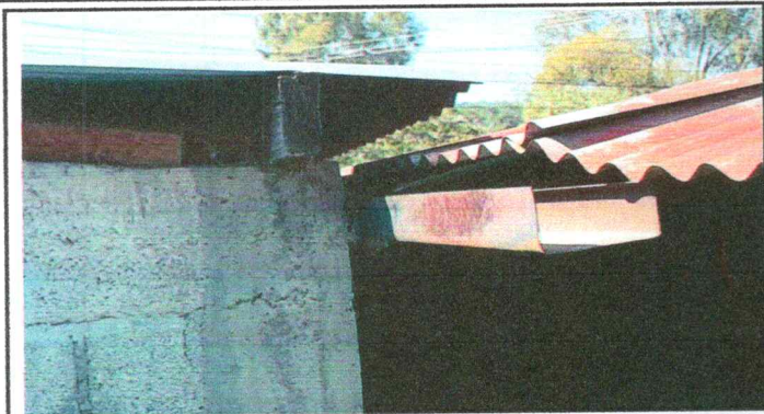
Foto 1: Sustitucion de canal.
