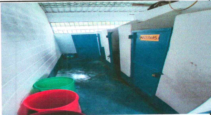
Foto 9: sustitucion de pintura en paredes
