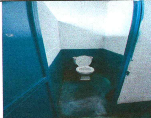
Foto 10: sustitucion de inodoros
