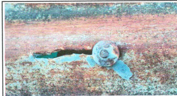
Foto 4: sustitucion de elementos de fijacion.
