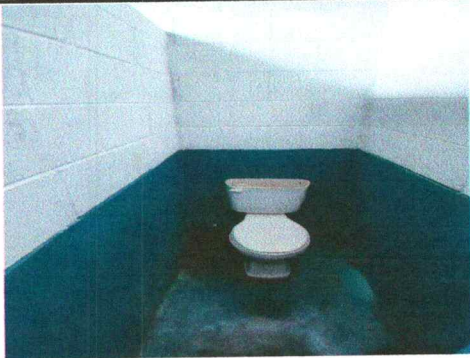
Foto 11: sustitucion de inodoros
