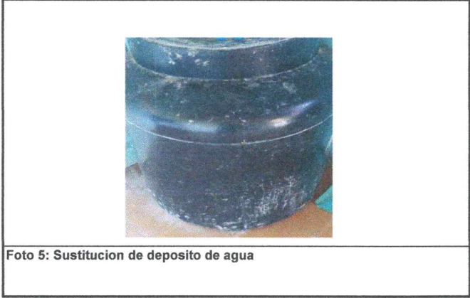
Foto 5: Sustitucion de deposito de agua
