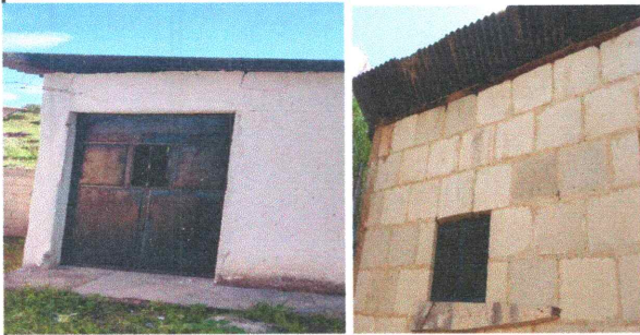
Foto 1: Sustitución de soporte de madera por metal cocina
