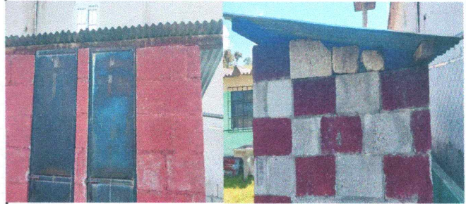
Foto 2: Sustitucion de soporte de madera por metal baños
