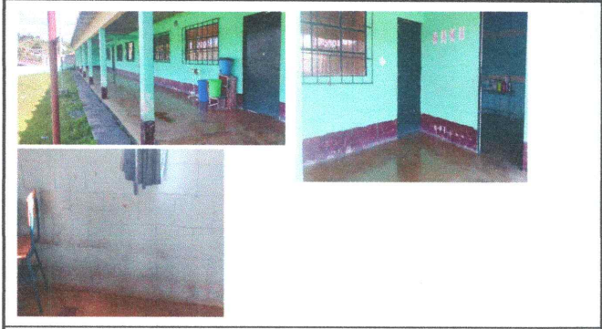
Foto 1: Pintura de exteriores e interiores
