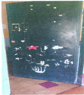
Foto 3: Mantenimiento de puertas de metal
