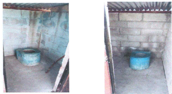
Foto 6: Sustitucion de servicios sanitarios
