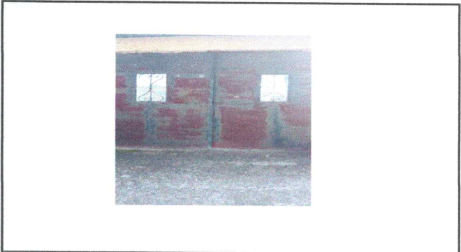
Foto 2: Mantenimiento de porton
