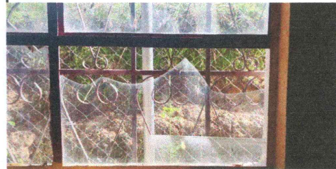
Foto 4: Sustitucion de vidrios
