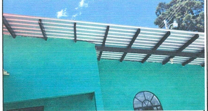
Foto 2 Sustitución de lámina en mal estado, por lámina troquelada calibre 26
