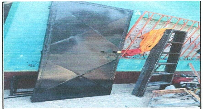
Foto 4: Mantenimiento a puerta de metal, lijado, pintura, chapa nueva
