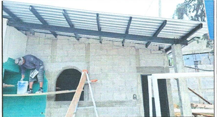
Foto 2: Sustitución de lámina en mal estado, por lámina troquelada calibre 26
