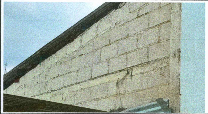
Foto 8: mejoramiento de cubierta.
