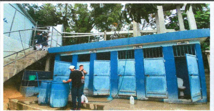
Foto 9: Mejoramiento de pintura
