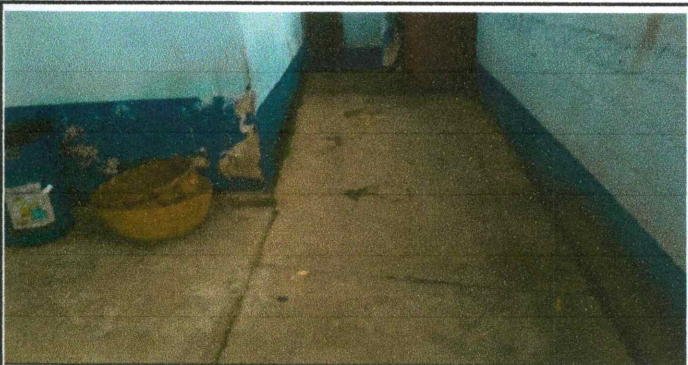
Foto 10: Mejoramiento de pintura
