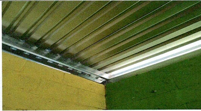
Foto 1: Sustitución de lamina del aula
