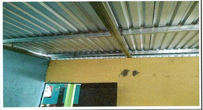
Foto 2: Sustitución de estructura de madera por metal
