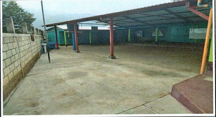
Foto 4: Reparación de planchas de concreto de patio
