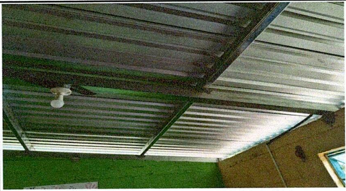
Foto 3: Instalación de unidades de luz
