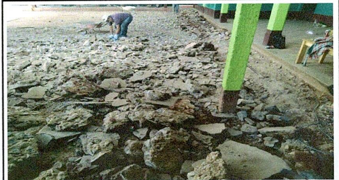
Foto 4: Reparación de planchas de concreto de patio
