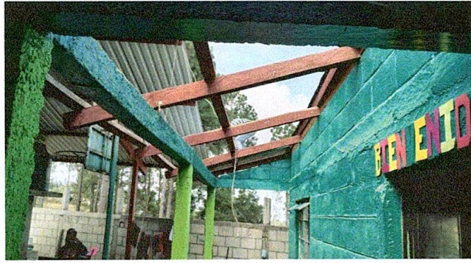
Foto 1: Sustitución de lamina del aula
