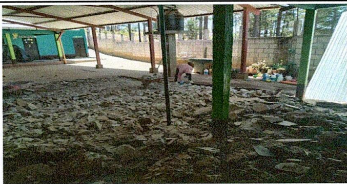
Foto 5: Reparación de planchas de concreto en pila principal
