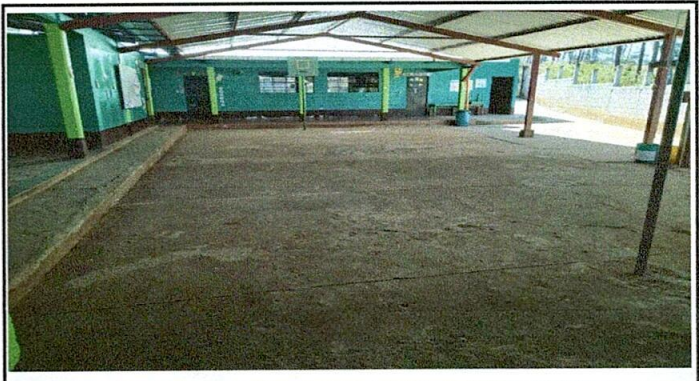
Foto 4: Reparación de planchas de concreto de patio
