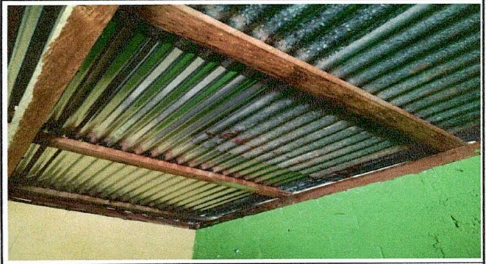
Foto 2: Sustitución de estructura de madera por metal
