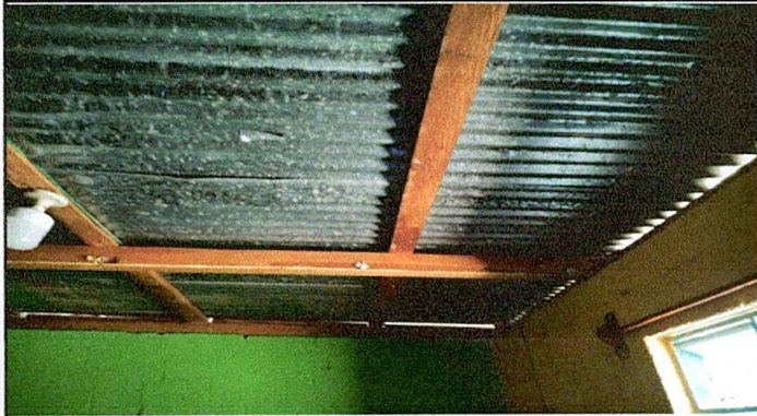
Foto 1: Sustitucion de lamina del aula
