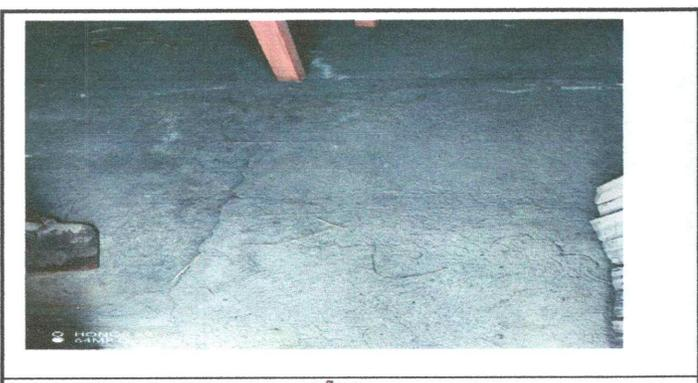
Foto 5: TORTA DE CONCRETO DAÑADA
