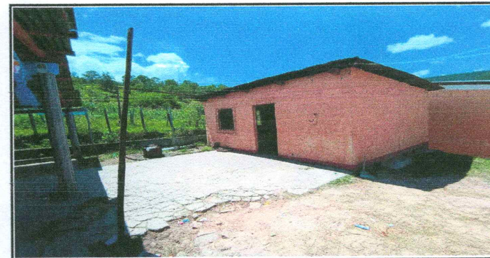
Foto 6: Sustitución de lámina
