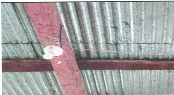
Foto 9: Sustitución de plafoneras
