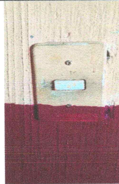
Foto 14: Sustitución de interruptores simples.
