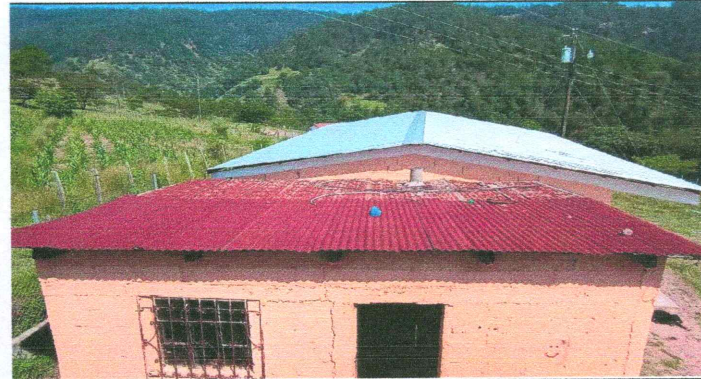
Foto 4: Sustitución de lámina
