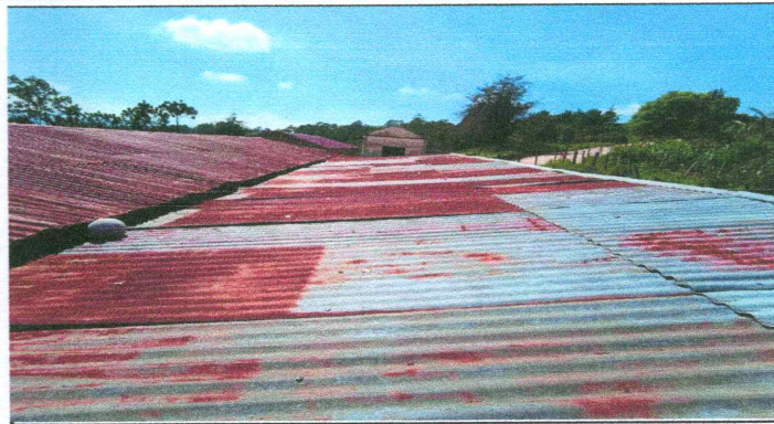
Foto 2: Sustitución de lámina
