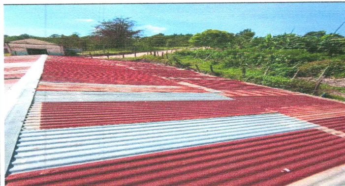
Foto 3: Sustitución de lámina
