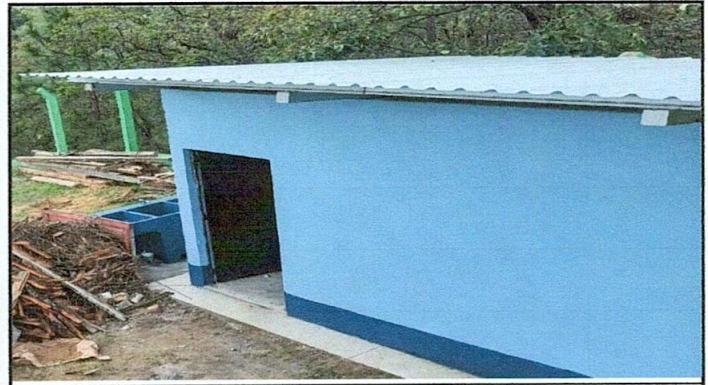
Foto 4: Sustitución de puerta de madera por puerta de metal de la cocina
