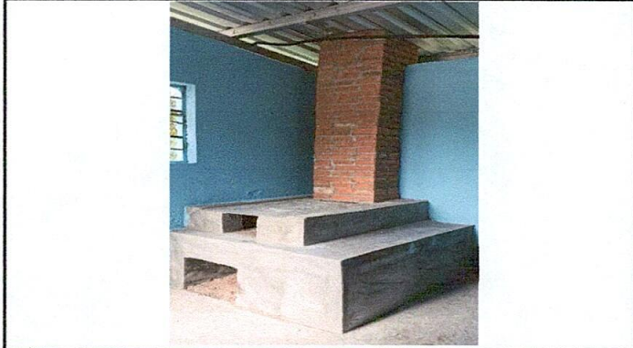
Foto 7: Sustitución de estufa artesanal (base, cambio de plancha)
