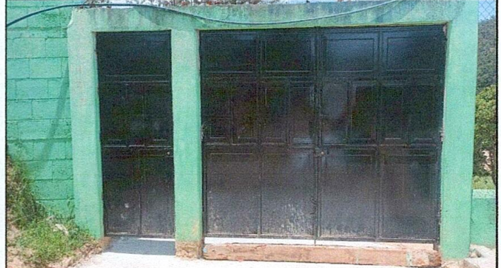
Foto 2: Sustitución de puertas de metal portón y puerta de entrada principal
