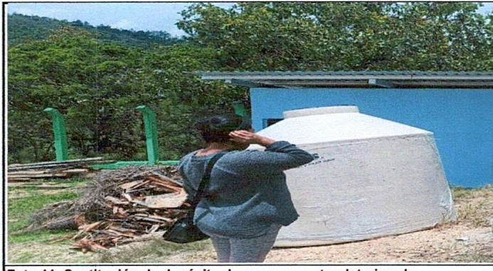
Foto 11: Sustitución de depósito de agua por estar deteriorado.
