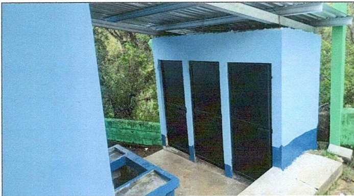
Foto 3: Sustitución de puertas de metal de los sanitarios.
