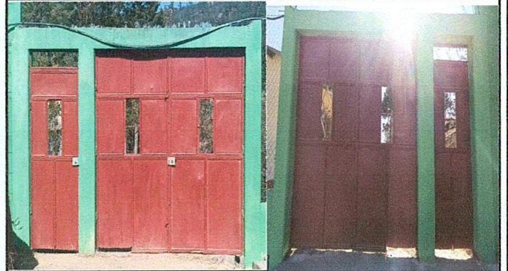
Foto 2: Sustitución de puertas de metal portón y puerta de entrada principal
