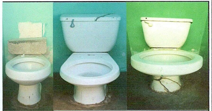
Foto 6: Sustitución de tres servicios sanitarios.
