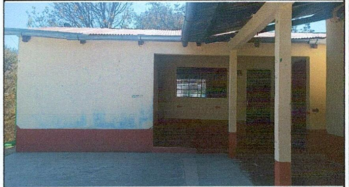
Foto 8: Sustrucción de canales.
