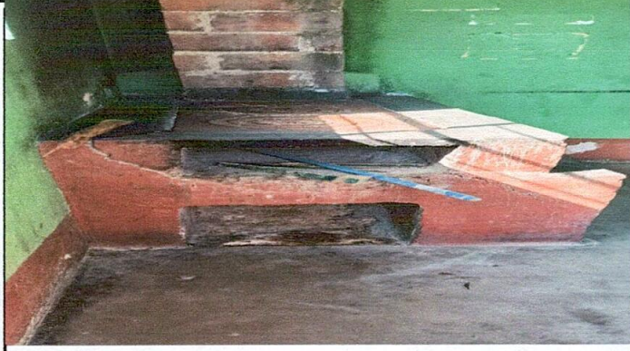
Foto 7: Sustrucción de estufa artesanal (base, cambio de plancha)
