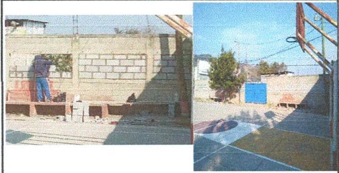
Foto 6: REMOZAMIENTO MURO PERIMETRAL DE LA CANCHA POLIDEPORTIVA
