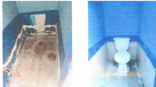
FOTO 3: SUSTITUCIÓN DE 5 INODOROS Y COLOCACIÓN DE ZÓCALO EN LOS MISMOS
