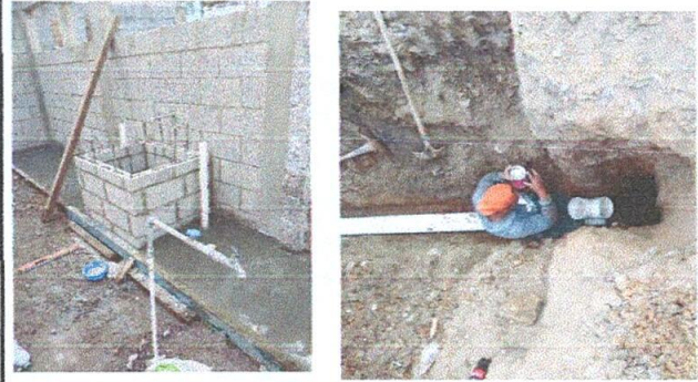
FOTO 4: SUSTITUCIÓN DE TUBERIA DE DRENAJE Y AGUA POTABLE
