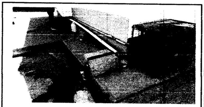
FOTO 4 SUSTITUCIÓN DE TUBERÍA DE DRENAJE Y AGUA POTABLE
