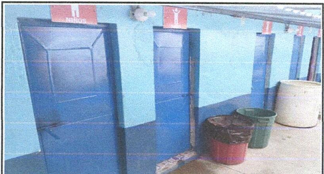
Foto 4: Herrería. Puertas de baños.
