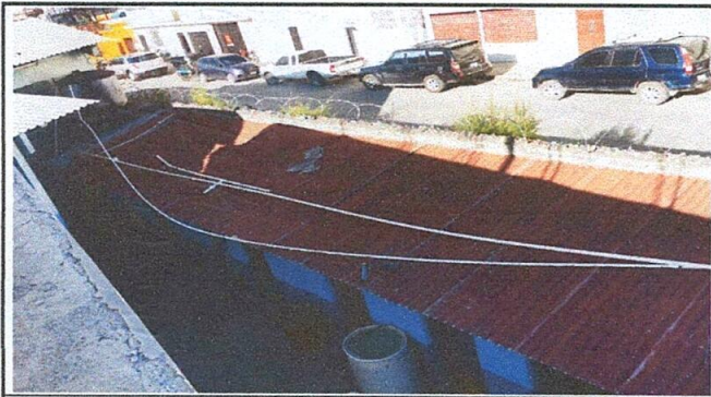
Foto: Techo de los Baños
