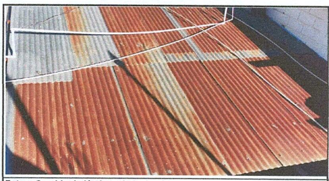
Fotos: Cambio de láminas de techo de patio
