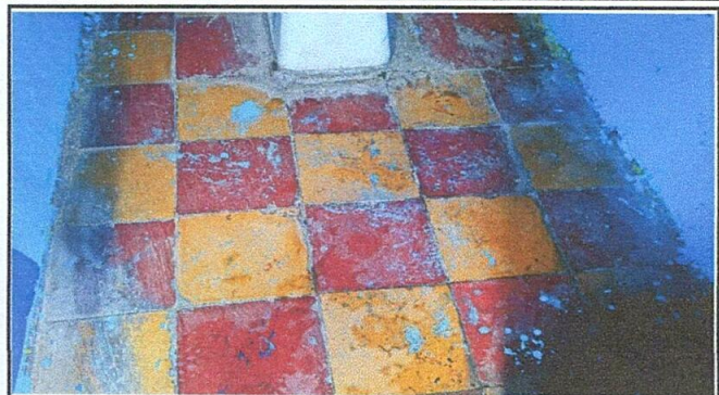
Foto: Piso de Baños
