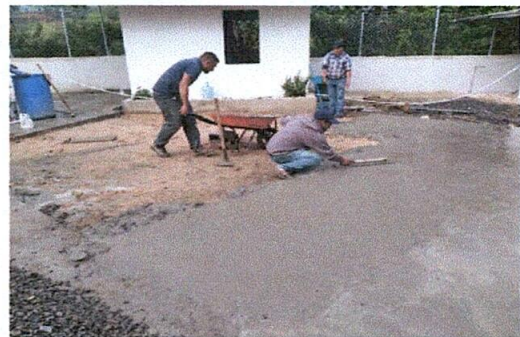
Foto 10. LOSA DE PATIO
