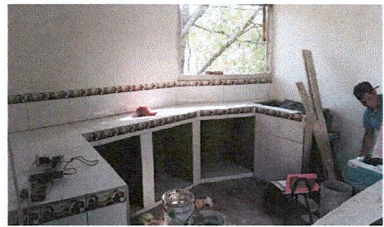
Foto 6: REPARACIÓN DE COCINA (GABINETES, PUERTAS, PLANCHA Y CHIMENEA)
