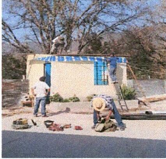
Foto 1: SUSTITUCIÓN DE LAMINA (MAL ESTADO)
