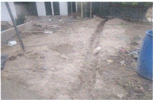
Foto 9. REPARACIÓN DE RED DE DRENAJE Y RED DE AGUA
