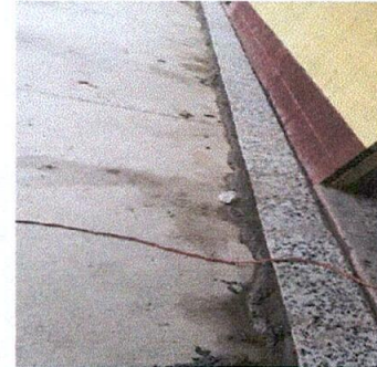
Foto 2: SUSTITUCIÓN DE TORTA DE CEMENTO POR PISO DE GRANITO
