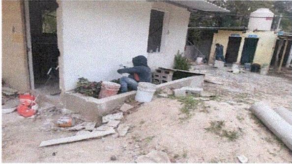
Foto 7. REPARACIÓN DE REPELLO Y CERNIDO DE PAREDES
