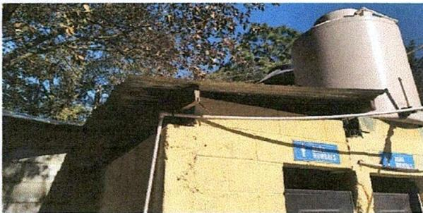
Foto 3: SERVICIO SANITARIO (LAMINAS AGRIETADAS SEMIPUESTAS)
