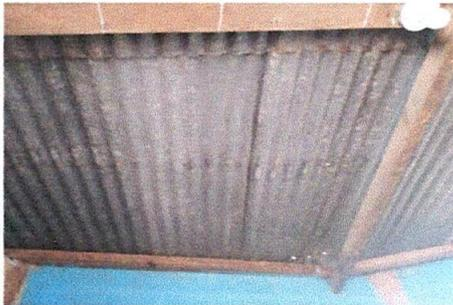
Foto 1: SUSTITUCIÓN DE LAMINA (MAL ESTADO)
