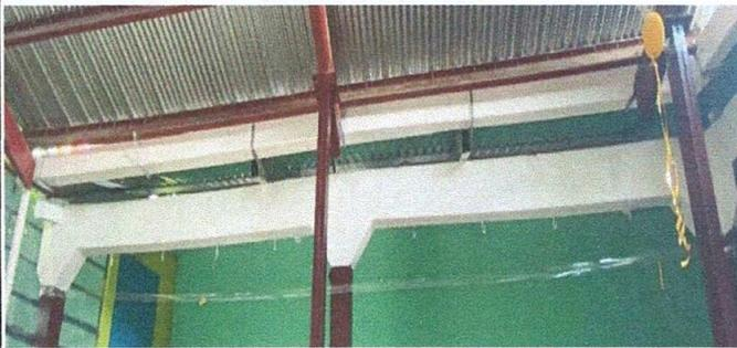
Foto 3: Sustitución de canal PVC
