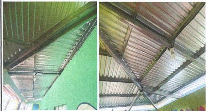
Foto 4: Sustitución de estructura de soporte de madera en mal estado, por estructura metálica.
