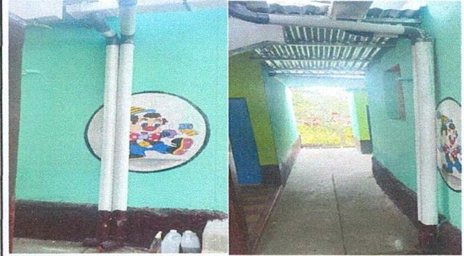
Foto 2: Sustitución de caída de agua pluvial
