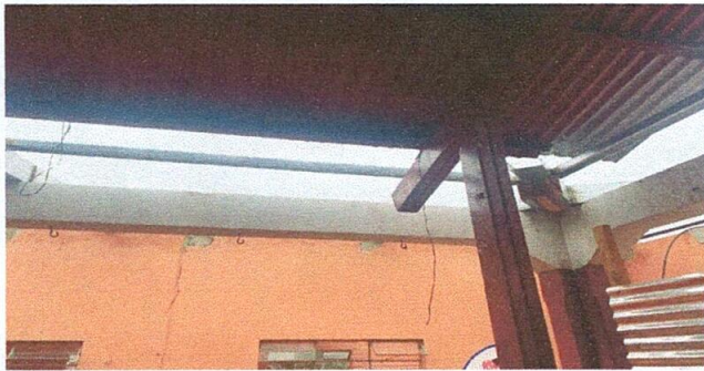
Foto 3: Removido los canales de metal en mal estado.
