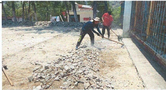
Foto 5: Levantado de planchas de patio en mal estado.
