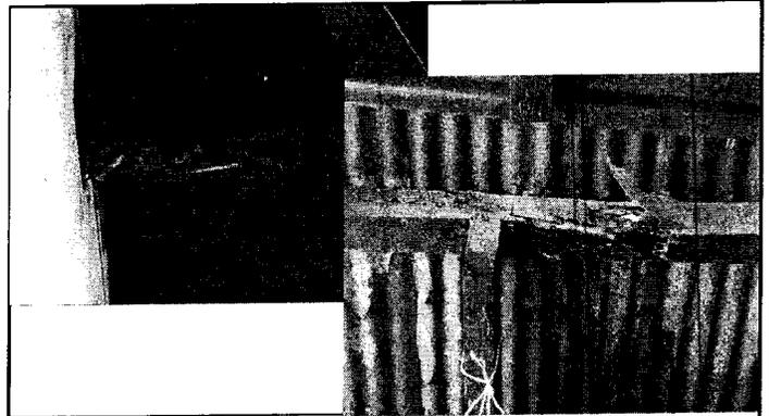
Foto 4: Sustrucción de estructura de soporte de madera en mal estado.
