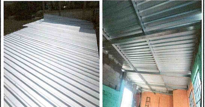
Foto 2: Sustitución de láminas en la cocina y Cambio de estructura de madera a metal.
