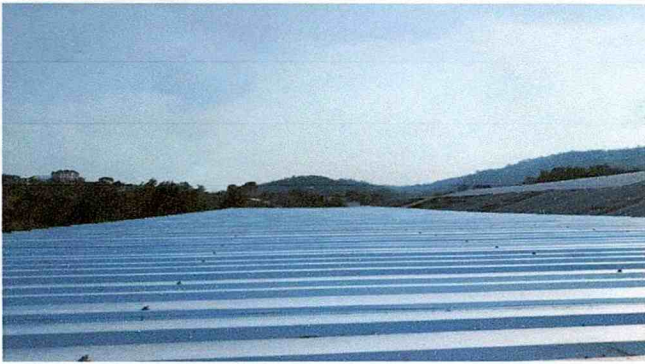
Foto1: Sustitución de láminas de las aulas en el segundo nivel.
