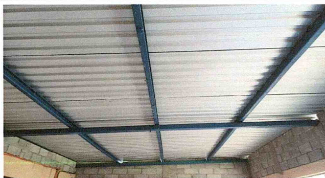
Foto 3: Mantenimiento de estructura de metal en las aulas del segundo nivel.
