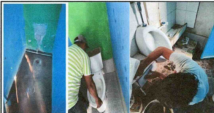
Foto 4: Sustitución de sanitarios y ampliación de un mingitorio.
