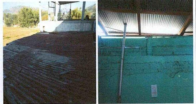
Foto 2: Sustrucción de láminas en la cocina y Cambio de estructura de madera a metal.
