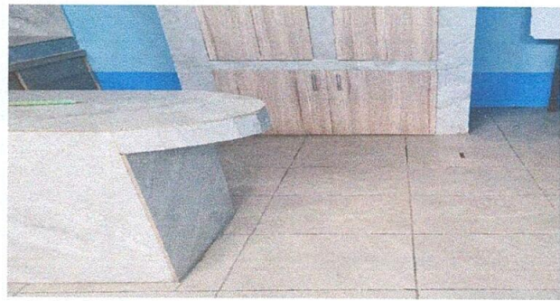
Foto 3: Sustitución de piso cerámico
