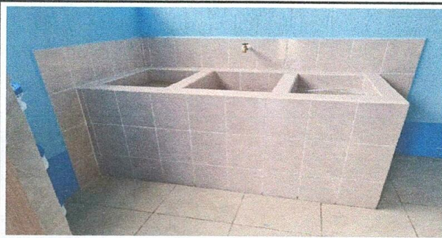
Foto 5: Sustitución de pila por pila fundidad
