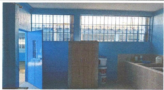
Foto 2: Mejoramiento de ventanas e iluminación
