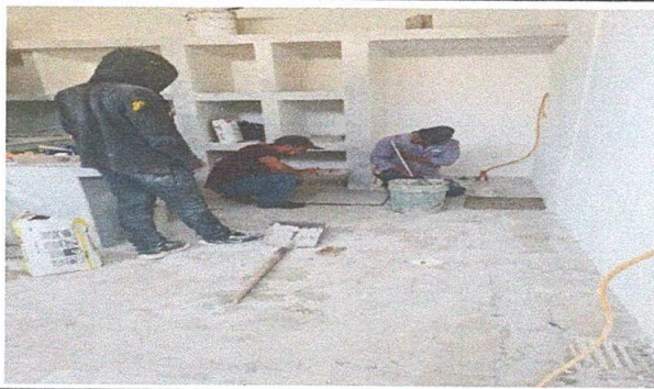
Foto 3: Sustitución de piso cerámico
