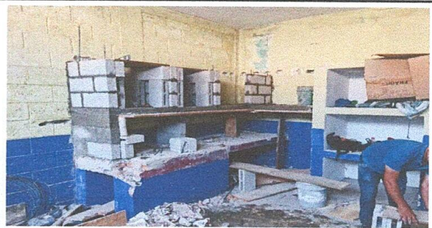
Foto 6: Sustitución de mueble de concreto en cocina
