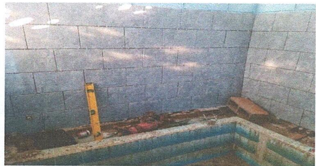
Foto 4: Sustitución de azulejo en baños
