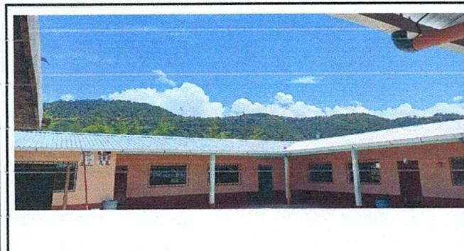
Foto 3: Techado con lámina troquelada
