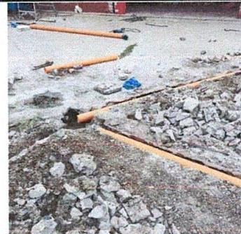
Foto 6: Tubería nueva para drenaje
