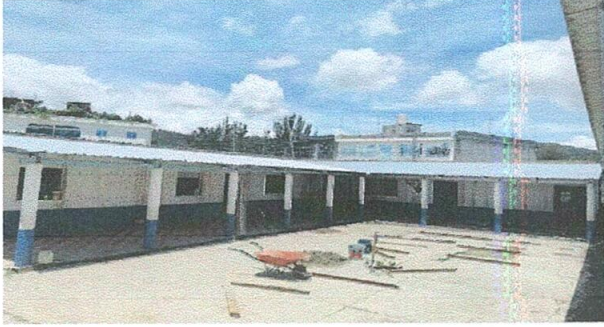
Foto 1: Sustitución completa de lámina módulo 1
