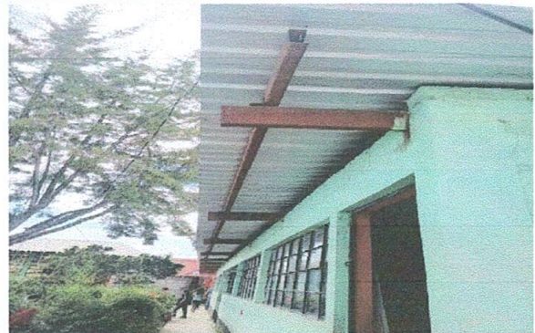
Foto 4: No se cambio estructura solo lámina en módulo 2
