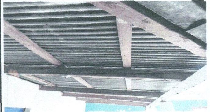
Foto 2: Modulo a escuadra cambio a costanera
