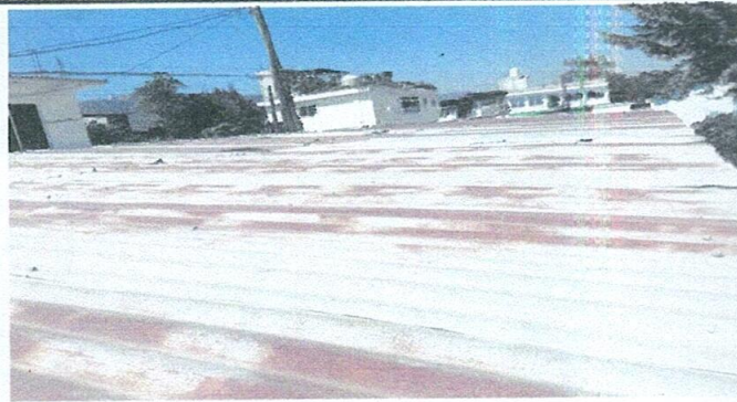
Foto 3: Modulo 2 sustitución de lámina
