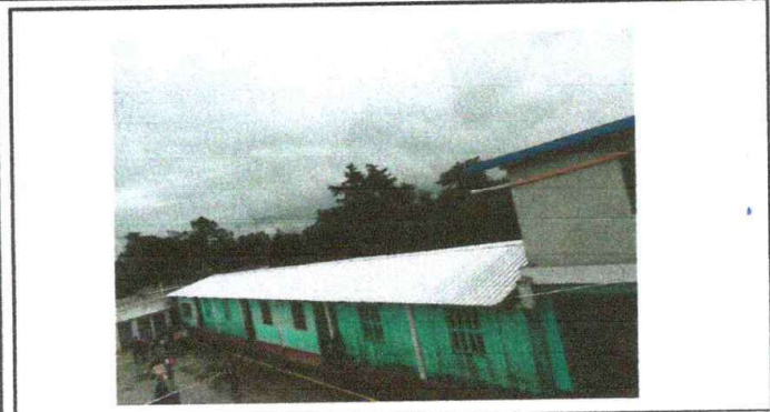
Foto1: Sustitución de Lámina acanalada por lamina troquelada aluzic
