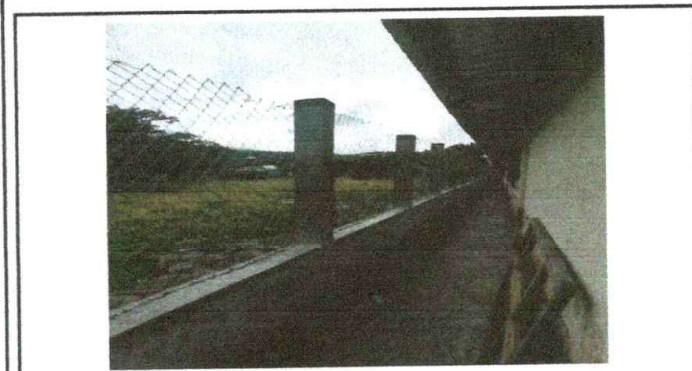
Foto 3: Reparación de Muro perimetral por block con tubo HG y malla
