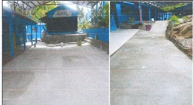
Foto 19: Pago de mano de obra por sustitución de 400 metros cuadrados de planchas de concreto de patios
