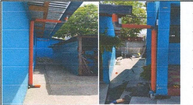
Foto 9: Sustitución de bajadas de agua pluvial de tubo 3"
