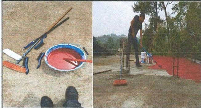
Foto1: Impermeabilización de losa
