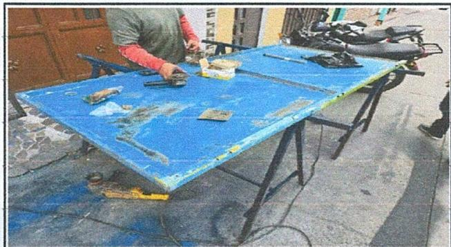
Foto 3: Sustitución de chapas de puertas de metal
