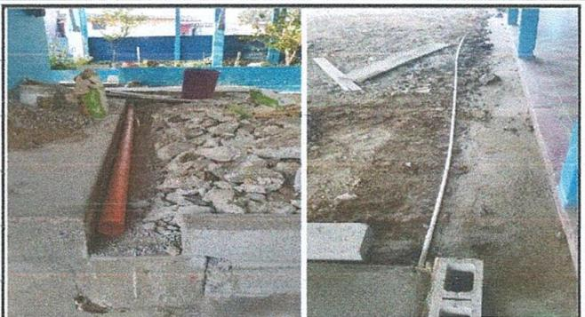
Foto 14: Reparación de red de drenaje y agua potable
