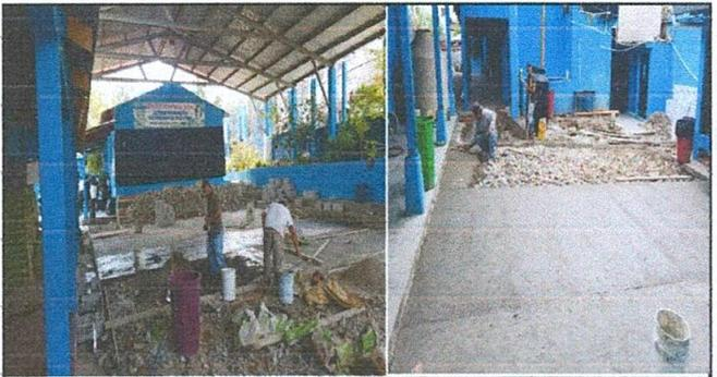
Foto 18: Sustitución de planchas de concreto de patio
