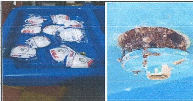
Foto 11: Sustitución de plafoneras para focos
