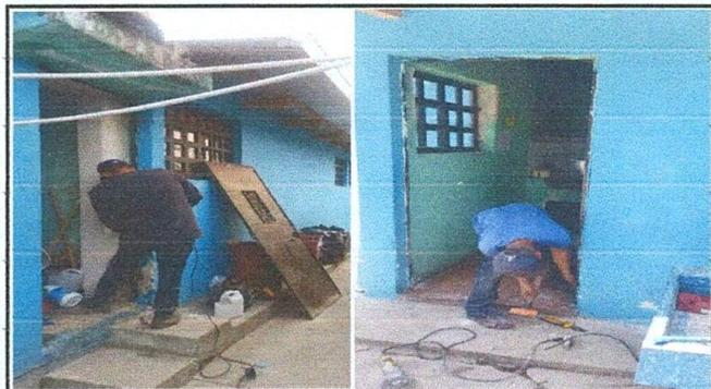
Foto 4: Sustitución de puertas de metal (cocina y bodegas)
