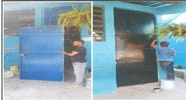
Foto 2: Mantenimiento de estructura de puerta de metal
