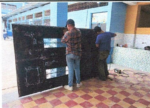
Foto 5: Mejoramiento de puestas de la cocina.
