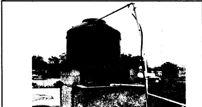
Foto 4: El tinaco que distribuye agua para el ambiente de la cocina ya esta deteriorado, por lo que se necesita su sustitución.
