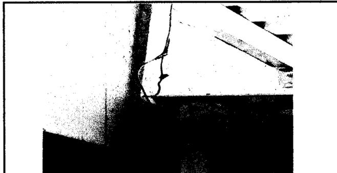
Foto 5: La red de energía eléctrica se encuentra en mal estado en algunas aulas y la cocina, por lo que se necesita sustitución del cableado.
