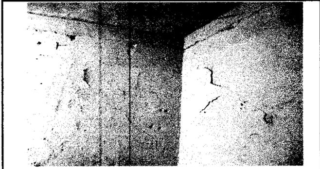
Foto 1: El repello de paredes se encuentra en muy deteriorado por lo que necesita sustitución.
