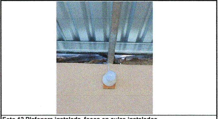
Foto 12 Plafonera instalada, focos en aulas instalados
