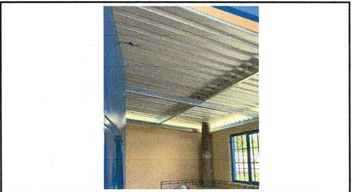
Foto 2: Lámina instadada y nueva en la cocina.
