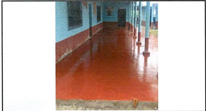
Foto 3: Corredor y patio terminado por completo.
