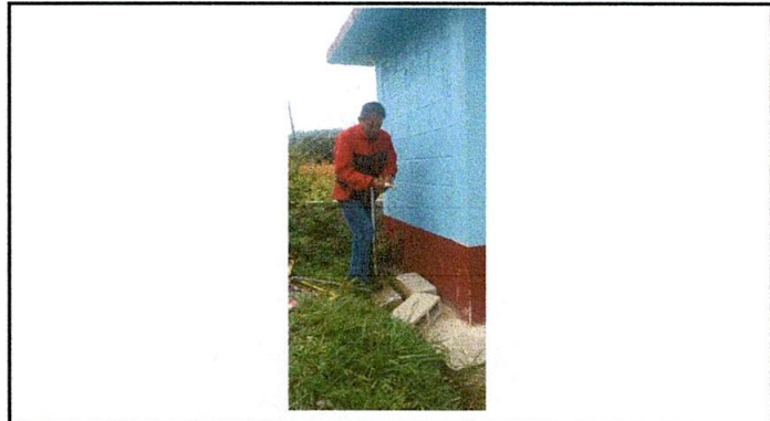
Foto 14 Cambio de chorro en baño
