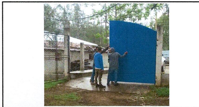
Foto 5 Sustitución del portón de maya por metal
