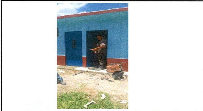
Foto 15 Sustitución de puertas en los baños
