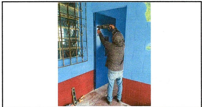
Foto 6: Están cambiando e instalando las puertas nuevas en las aulas de la escuela y dirección.
