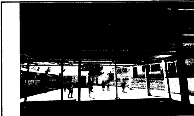
Foto 3: SUSTITUCION DE ESTRUCTURA DE SOPOTE DE MADERA POR METAL
