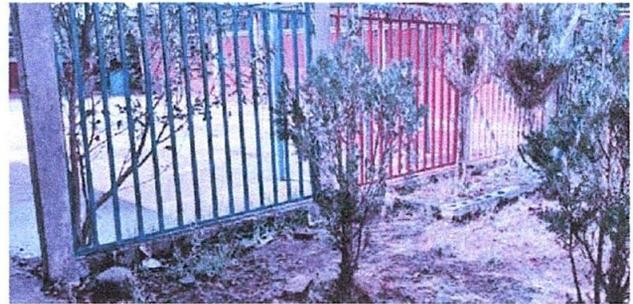
Foto 6: Sustitución de malla en muro perimetral por rejas metálicas
