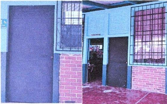
Foto 3: Sustitución de puerta pre - fabrica por puerta de metal
