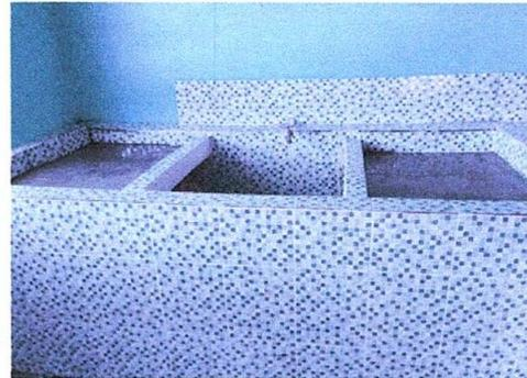
Foto 4: Sustitución de Pila de concreto por pila de concreto, fundida en el lugar
