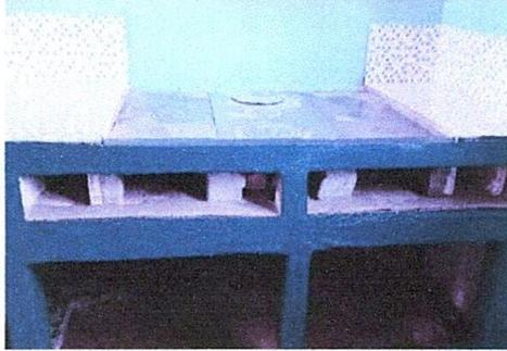
Foto1: sustitución de estufa rural (completa) Incluye chimenea y plancha de metal
