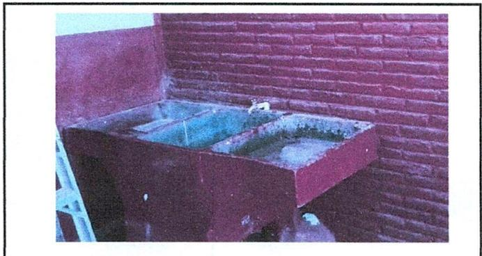
Foto 4: Sustitución de Pila de concreto por pila de concreto, fundida en el lugar
